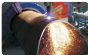
Öffnungsschnitt am Rohr Cutting of opening on a pipe
