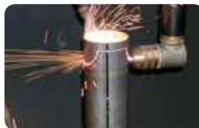
Rohrschnitt Pipe cut
